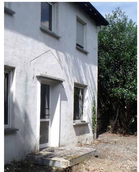
Het te slopen pand
