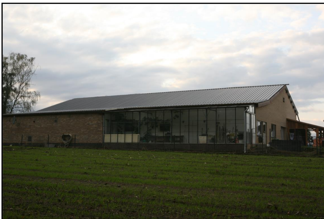
Afbeelding 11: aanwezige schuur met vervolgfunctie vakantieappartementen met berging en atelier en kas aangrenzend aan de bestemming Agrarisch met waarden- Landschapswaarden 1.
