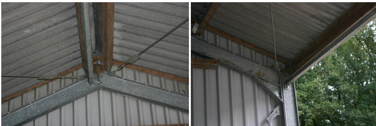
Figuur 4.4.3. In de te slopen half open schuur zijn aan de oostzijde een oud nest van merel (links) en houtduif (rechts) waargenomen.
