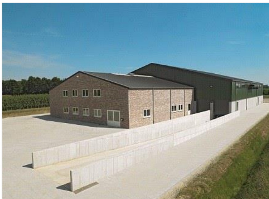
Foto bestaande situatie
