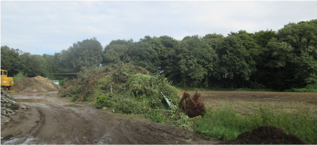
1. Zuidelijke erfrens, bouwblok loopt over in zuidelijk gelegen akker.
