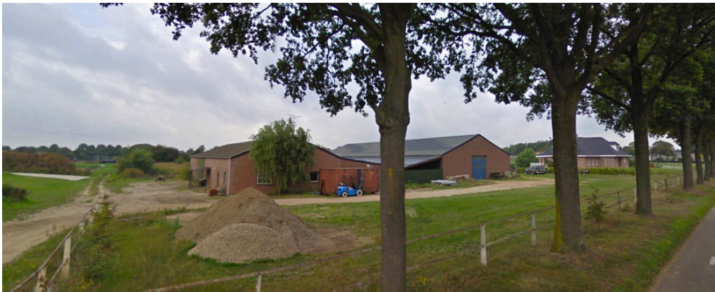
2. Aan voorzijde is er ruimte voor parkeren, enkel een houten hekwerk begrensd het erf.
