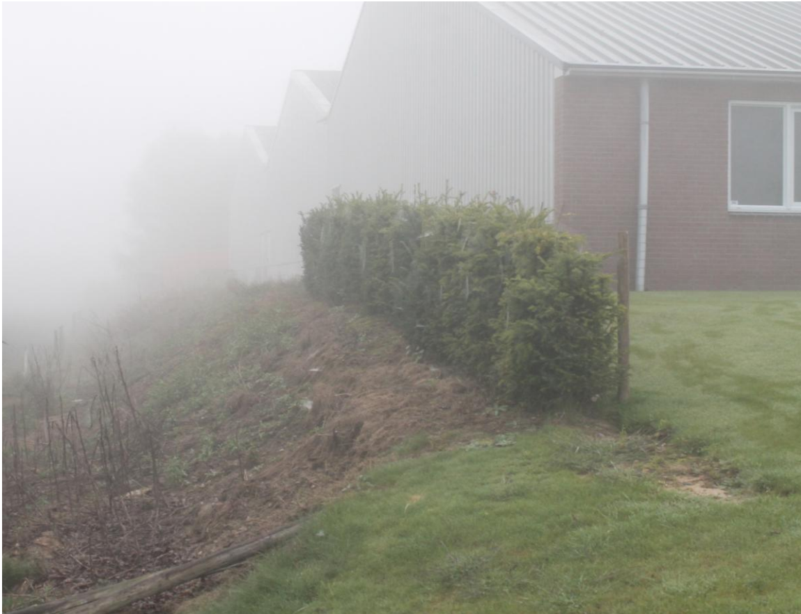
Foto: bestaande situatie met talud en aanwezige Taxushaag.
