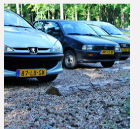
Parkeren Puingranulaat/halfverharding met stootbanden
