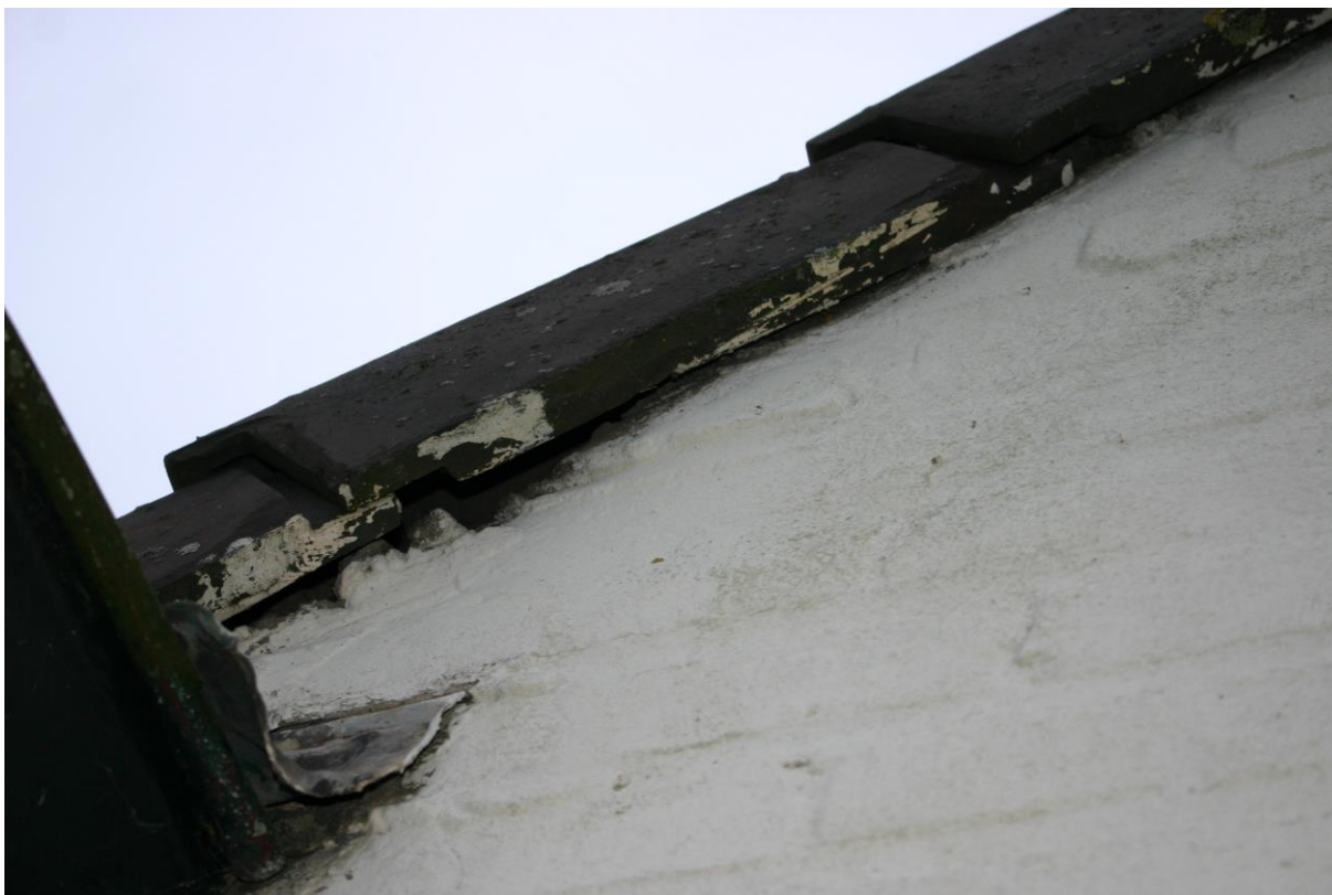
Figuur 3. Via de kier onder deze gevelpan kunnen kleine zoogdieren als vleermuizen de spouw bereiken.
