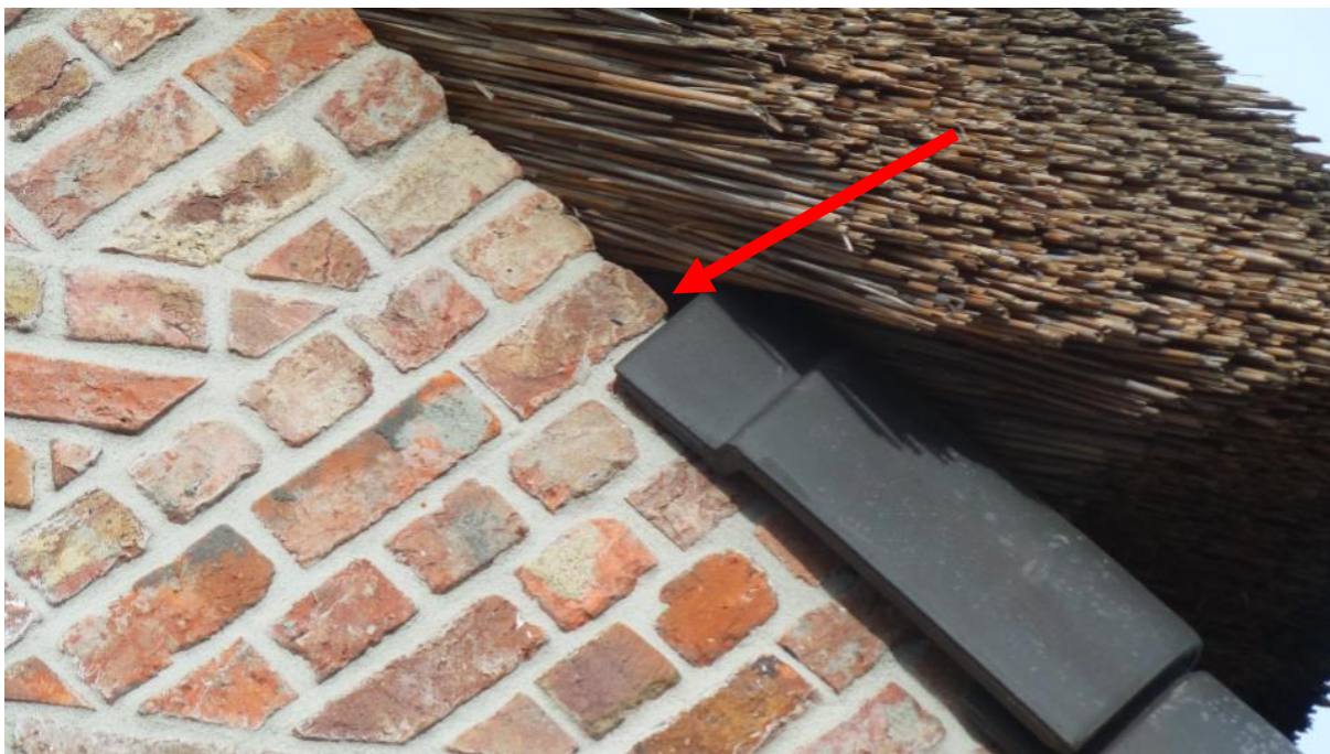
Figuur 5. Vier cm brede opening (rode pijl) die vleermuizen toegang kan geven tot de spouw bij de woning aan Lensheuvel 76a.
