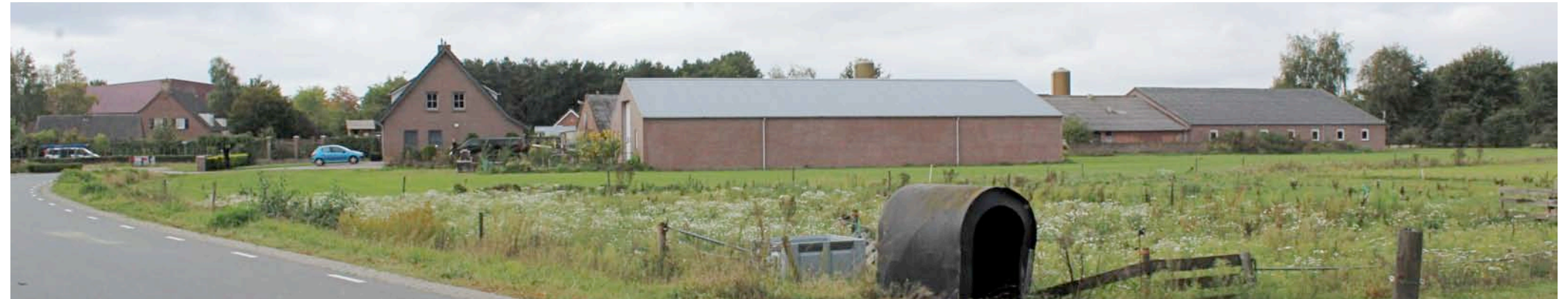
1) Rouwenbogt; de loods en de stal tonen zich kaal aan het verkeer
