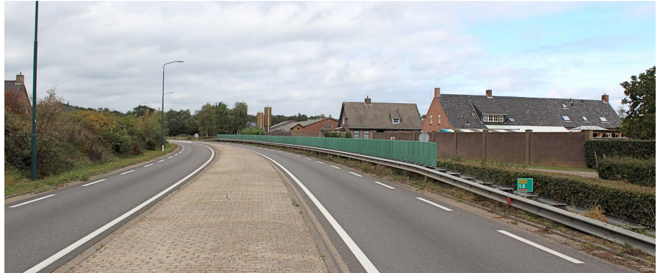
1) vanaf de Randweg komend uit het zuidoosten; geluidwerende voorzieningen en silo's bepalen het beeld
