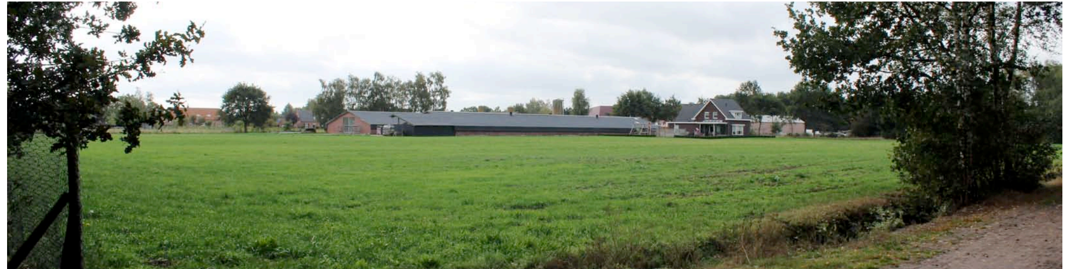
1) vanaf de veldweg is een zicht op de noordoostkant en de noordwestkant mogelijk; de stallen tonen zich kaal ...
