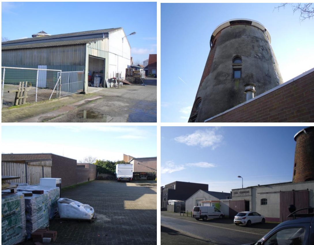
Afbeelding 2.2: Overzicht bestaande situatie (zuidelijk deel)
