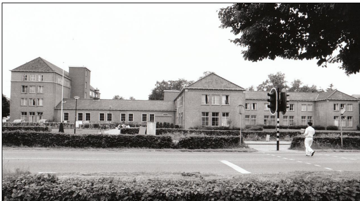
Figuur 3: Het Franciscus van Salesklooster in 1994 (noordoostelijke deel plangebied), dan in gebruik als asielzoekerscentrum (Bron: www.ed.nl ).
