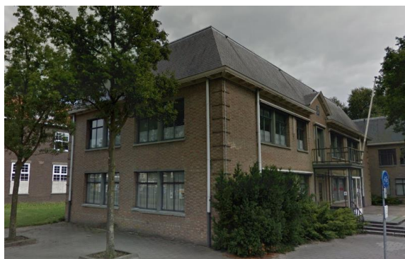
Figuur 4.5. Foto van het inmiddels gesloopte voormalige gemeentehuis. Bron: Google Street View.
