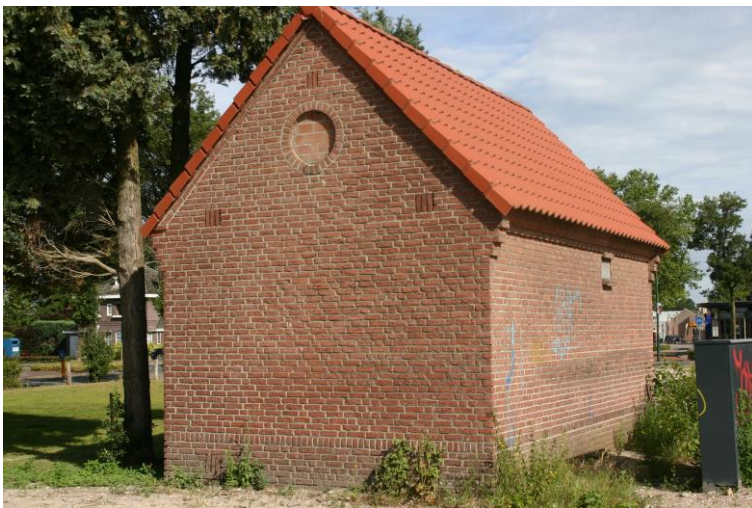
Figuur 4.1.2. Het elektriciteitshuisje.
