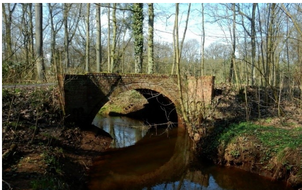
Bakstenen bruggetje over de Reusel. Foto J. van der Heijden.
