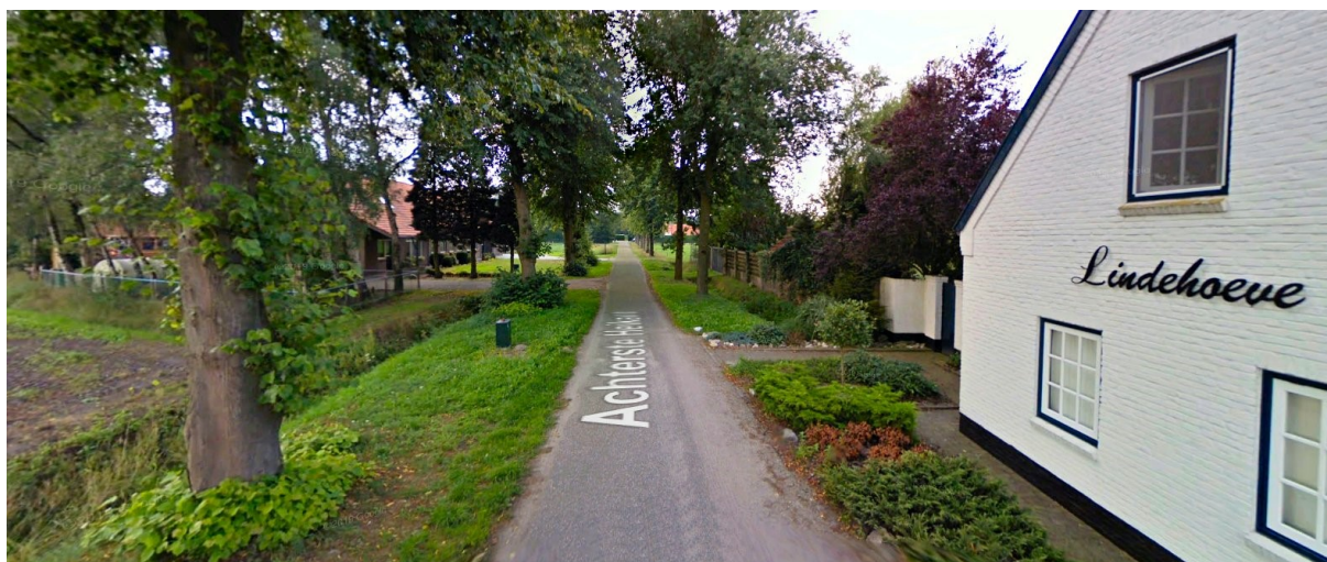
Kijkje in de Achterste Heikant. Foto Google Streetview augustus 2010.
