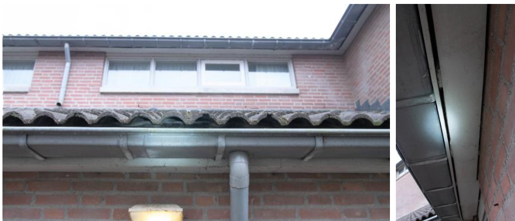
Geschikte openingen in de bebouwing voor gierzwaluw en huismus (foto's Laneco).
