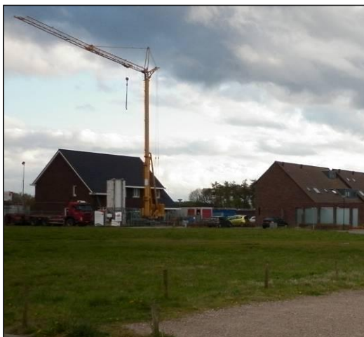
wijk De Hasselt in aanbouw
