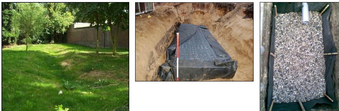
Figuur 13: Voorbeelden van infiltratiemogelijkheden
