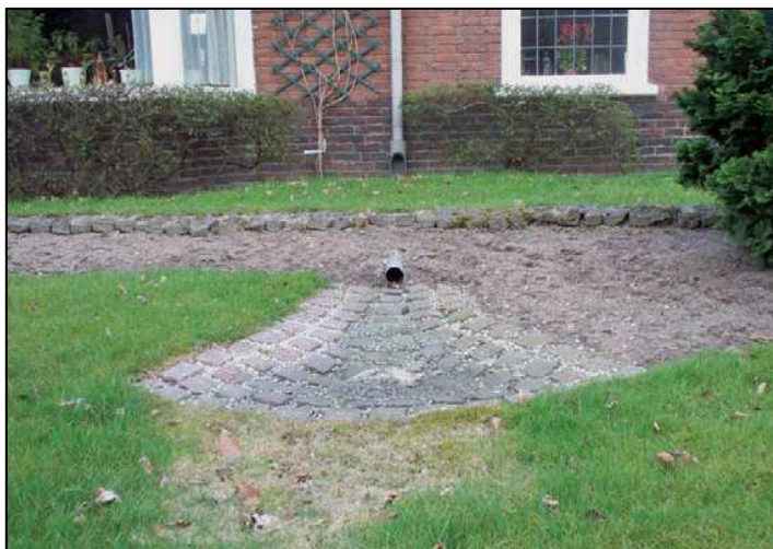
Figuur 32. Voorbeeld van een infiltratieveld.
