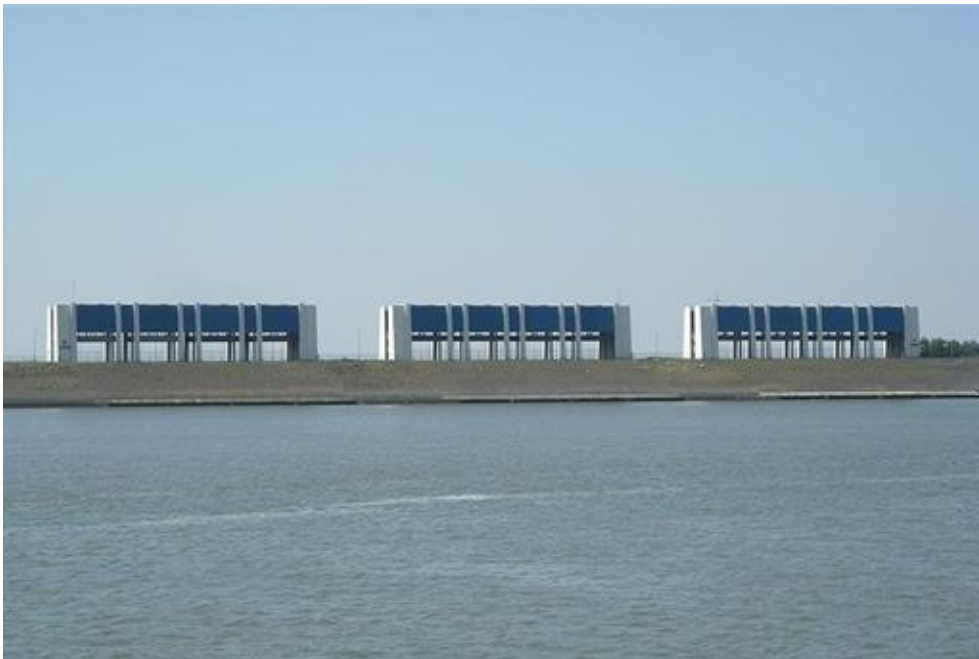
Figuur 6. Zicht op de R.J. Cleveringsluizen vanaf de Waddenzee
