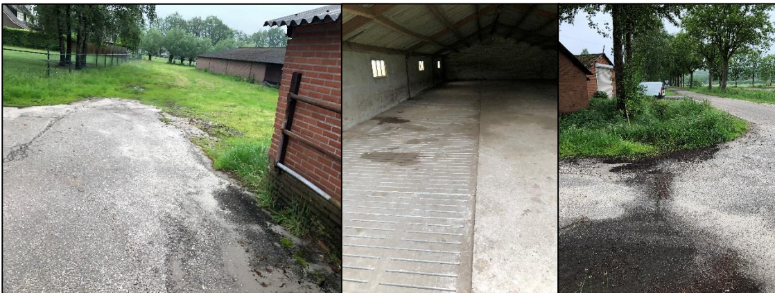
Figuur 12: Foto's van het plangebied. Links een blik op de locatie van boorpunt 5, genomen van tussen de stallen. Midden de binnenzijde van de meest zuidelijke stal met mestkelder. Rechts de locatie van boringen . Fotograaf: J. Rap.
