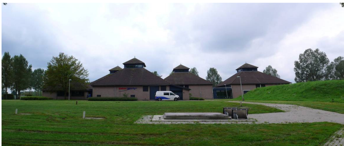
Foto 2.1 Bestaande bebouwing met rechts een reinwaterkelder
