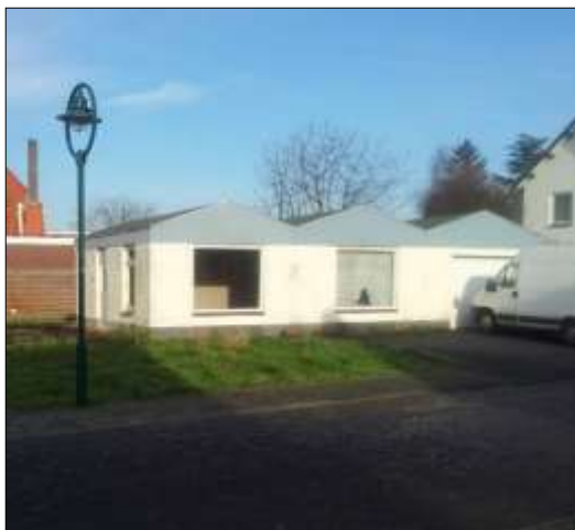
locatie nieuwe woning
