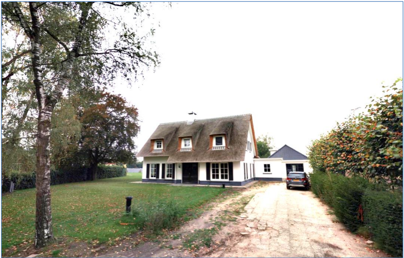
Afbeelding: Zicht vanaf de Brakenstraat (bron: Streetsmart)
