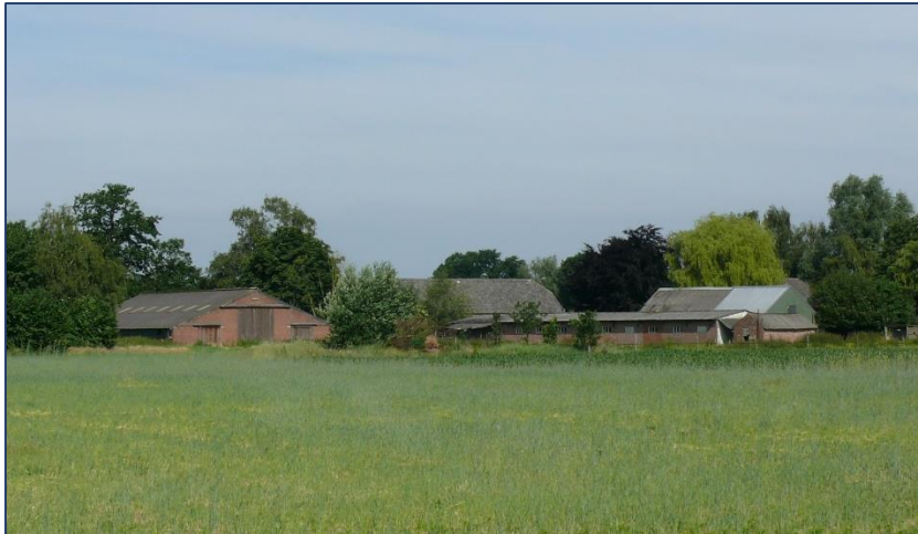
10 achterzijde bedrijfsgebouwen gezien vanaf Bemmer IV
