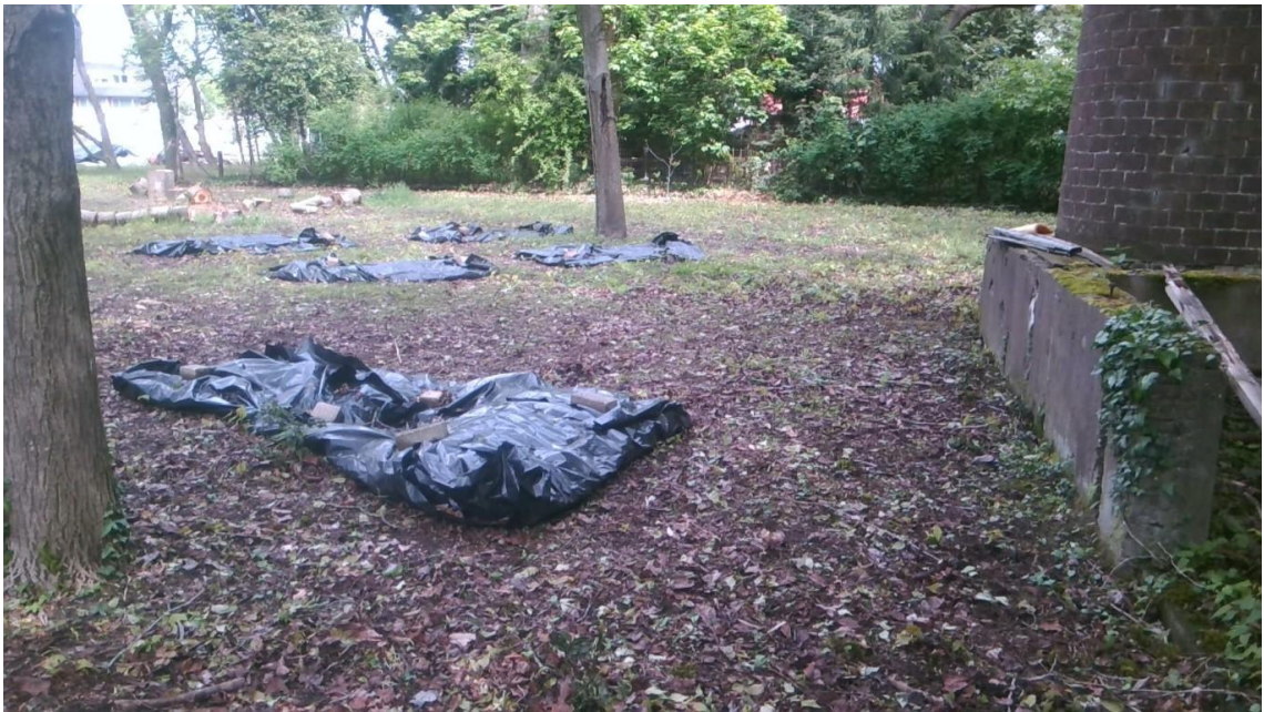
Afbeelding 6: opslag verpakte asbestplaat
