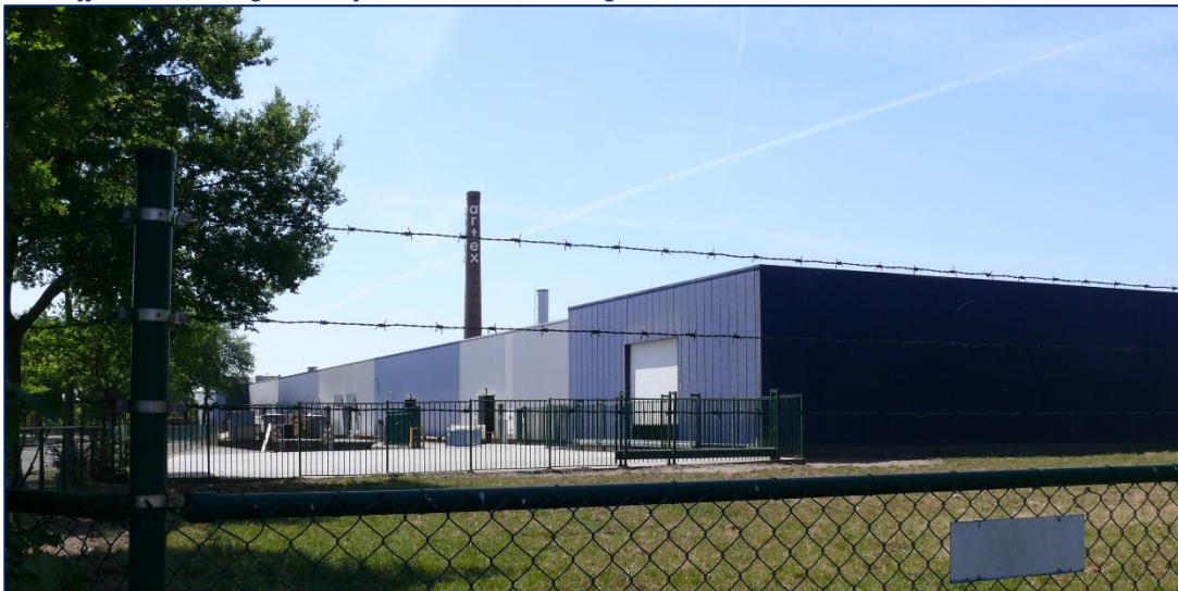
Bedrijfsbebouwing aan zijde Helmondseweg
