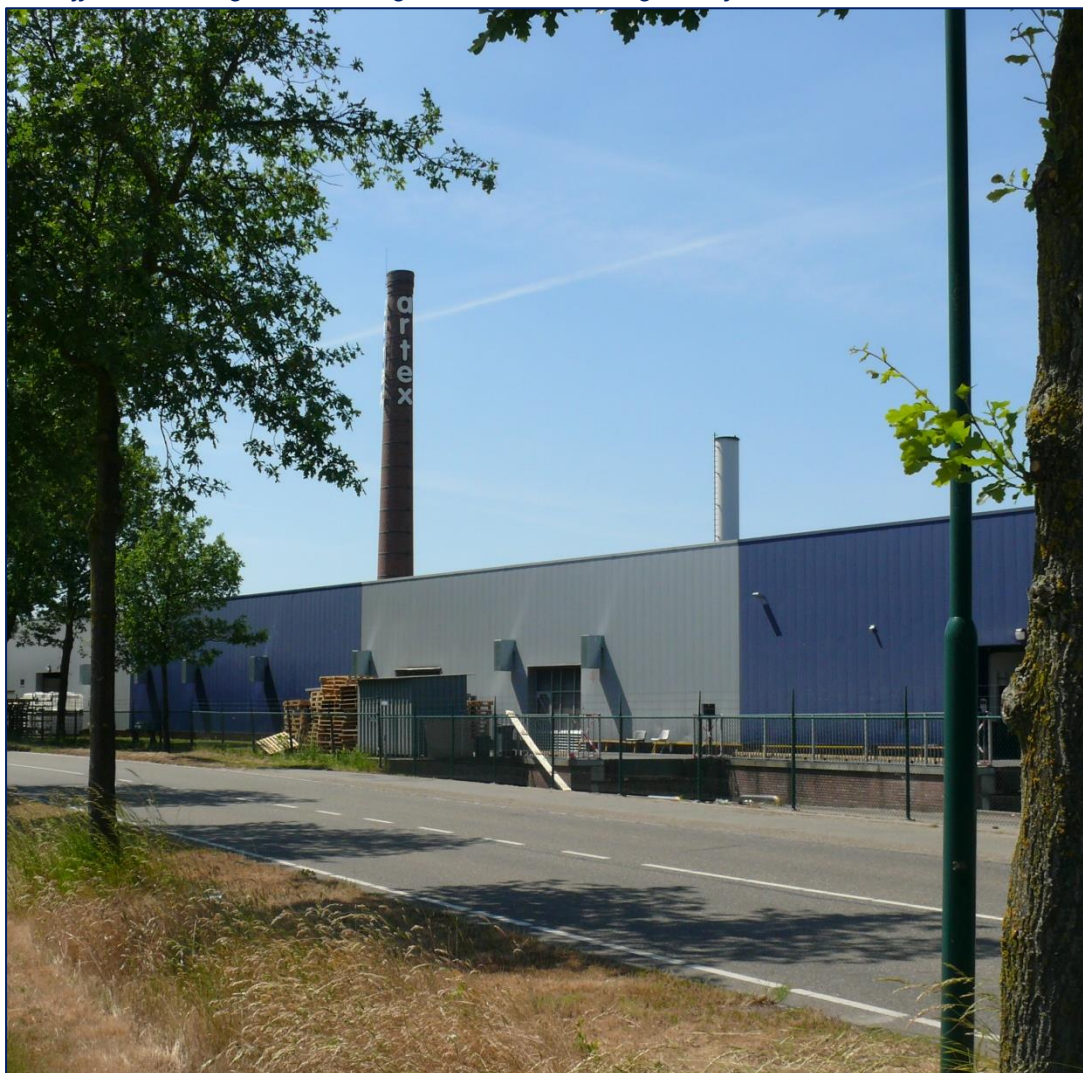
Bedrijfsbebouwing Bosscheweg 79 met rechts vergund afvoerkanaal
