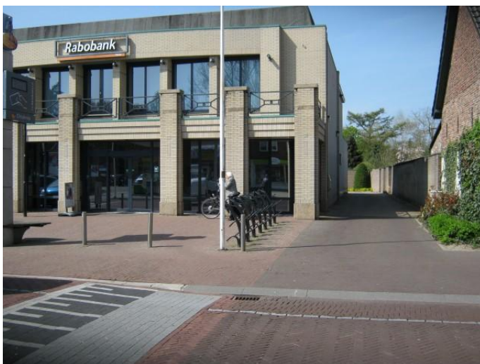
Foto 1: Kapelstraat 74 (gezien vanaf de Kapelstraat in westelijke richting)
