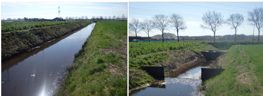
Afbeelding 5.2. Impressie sloot oost. Links: meest noordelijke deel van de sloot, Rechts: vaste stuw in het zuidelijke deel.
