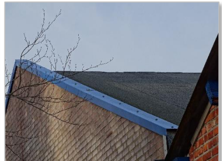
Foto 30: Dakbedekking voormalige drukkerij (bitumen dakleer/ geen openingen, kieren of spleten).
