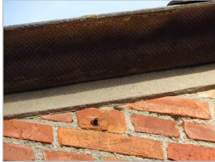
Foto 26: Kops kant dakrand voormalige drukkerij (geen openingen, kieren of spleten).
