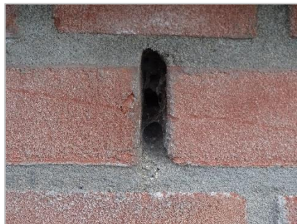
Foto 32: Stootvoegen gevels voormalige drukkerij (te smal voor toegang vlermuizen – let op spinrag in stootvoeg).
