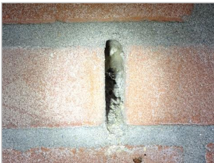
Foto 31: Stootvoegen gevels voormalige drukkerij (te smal voor toegang vlermuizen).
