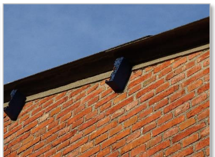
Foto 24: Kopse kant dakrand voormalige drukkerij (geen openingen, kieren of spleten).
