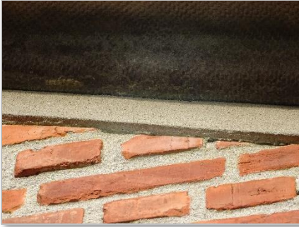
Foto 25: Kops kant dakrand voormalige drukkerij (geen openingen, kieren of spleten).
