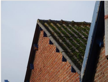
Foto 29: Dakbedekking voormalige drukkerij (bitumen golfplaten / geen openingen, kieren of spleten).
