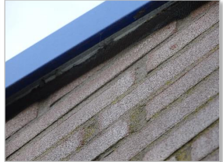
Foto 27: Kops kant dakrand voormalige drukkerij (geen openingen, kieren of spleten).
