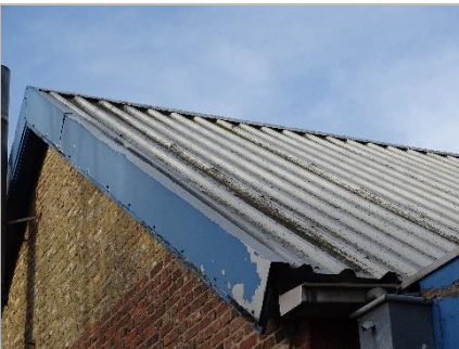
Foto 28: Dakbedekking voormalige drukkerij (stalen golfplaten / geen openingen, kieren of spleten).
