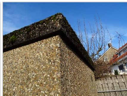
Foto 5: Trafohuisje (langs dakrand geen openingen tot interieur).
