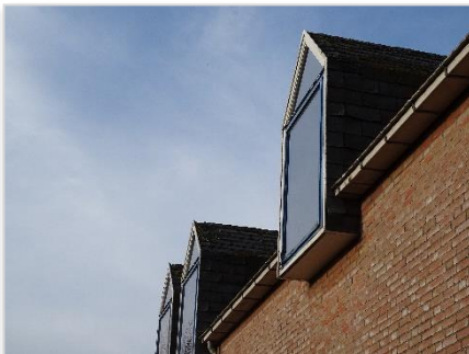
Foto 20: Dak/dakkapellen voormalige drukkerij.
