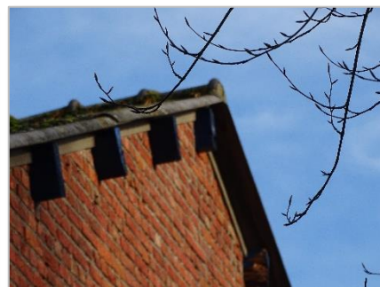
Foto 23: Kopse kant dakrand voormalige drukkerij (geen openingen, kieren of spleten).
