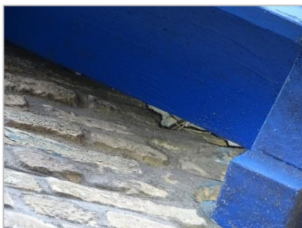
Foto 22: Kopse kant dakrand voormalige drukkerij (geen openingen, kieren of spleten).
