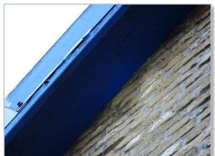
Foto 21: Kopse kant dakrand voormalige drukkerij (geen openingen, kieren of spleten).
