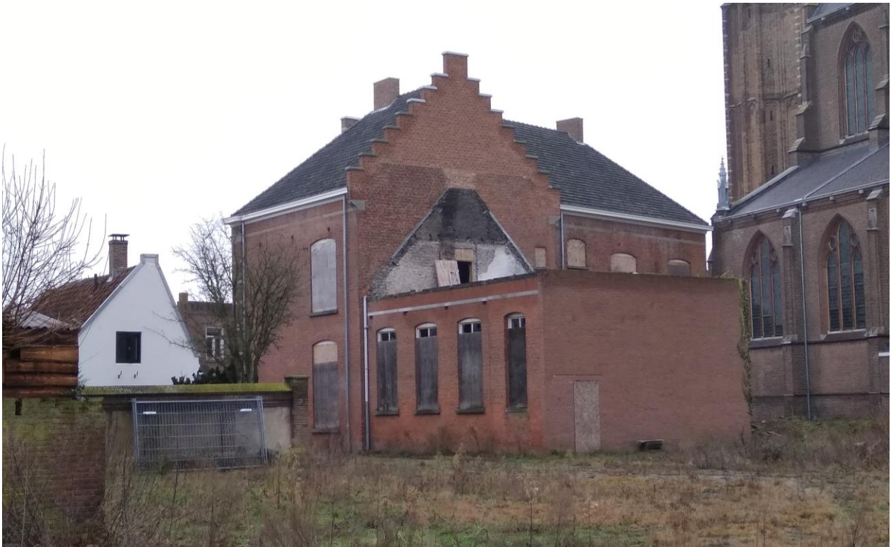
Figuur 4.5.3. De achterzijde van het klooster heeft nog altijd geen dak en is hierdoor makkelijk toegankelijk voor vogels en andere dieren.
