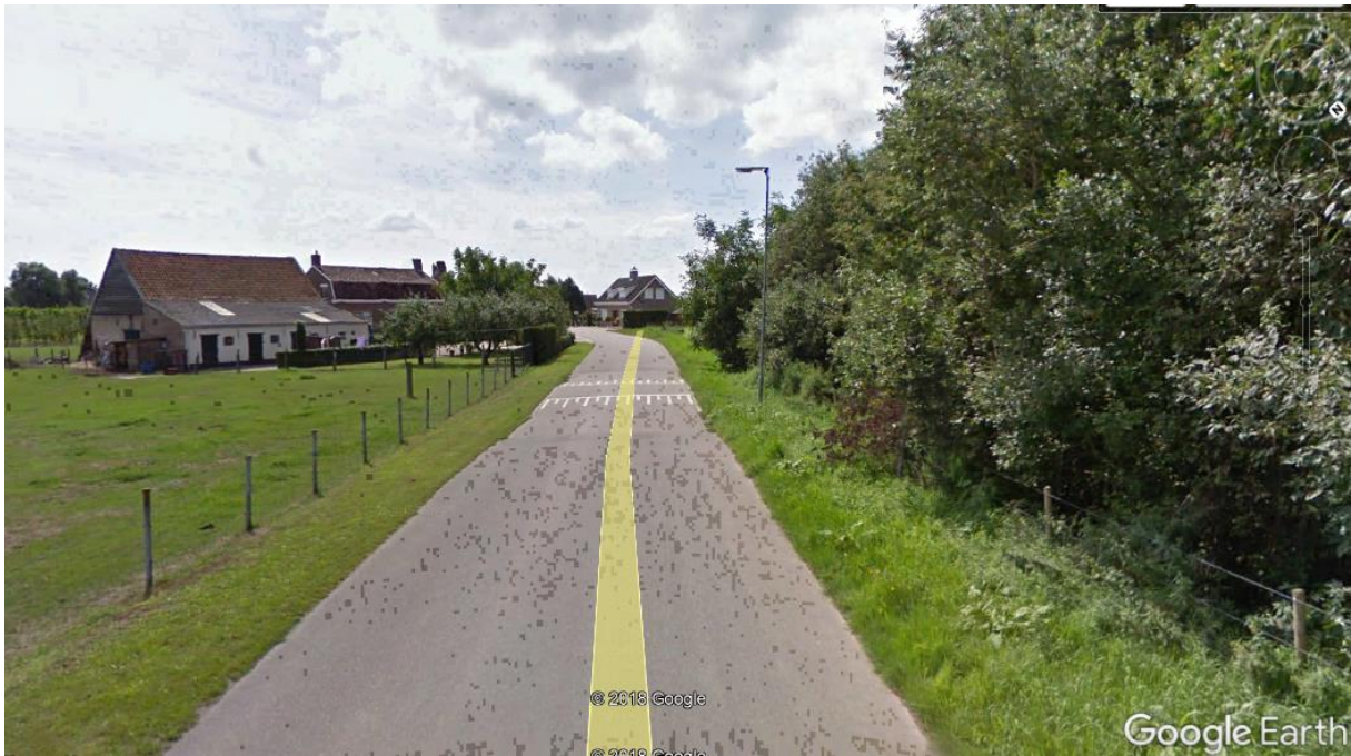
Fig. 7 Foto Oudendijk in zuidelijke richting.
