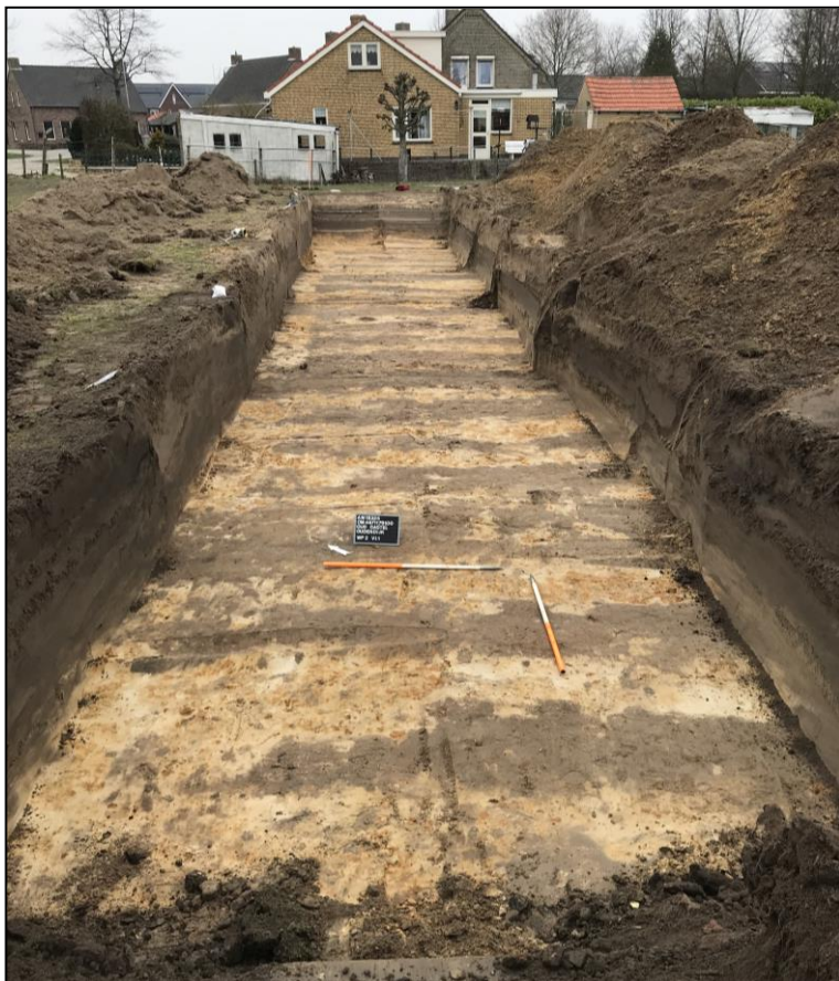
Figuur 10: Zicht op werkput 2 richting noordoosten.
