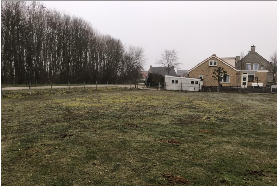
Figuur 5: Zicht op het terrein voor aanvang van de werkzaamheden. Gezien in noordelijke richting (Foto: 22 februari 2019).
