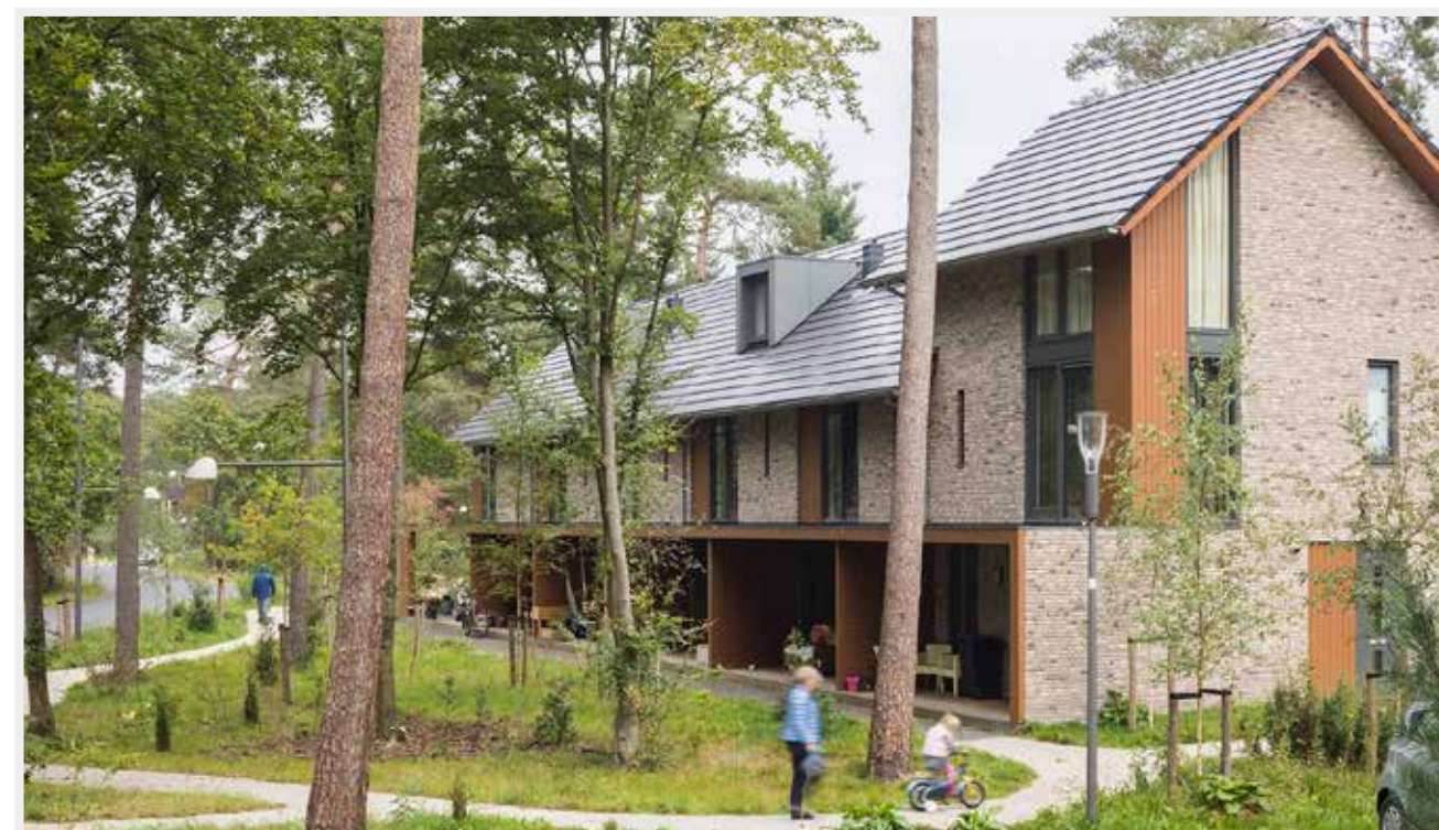
Bijzondere hoekoplossing met hoger bouwvolume met overhoeks gevelontwerp
