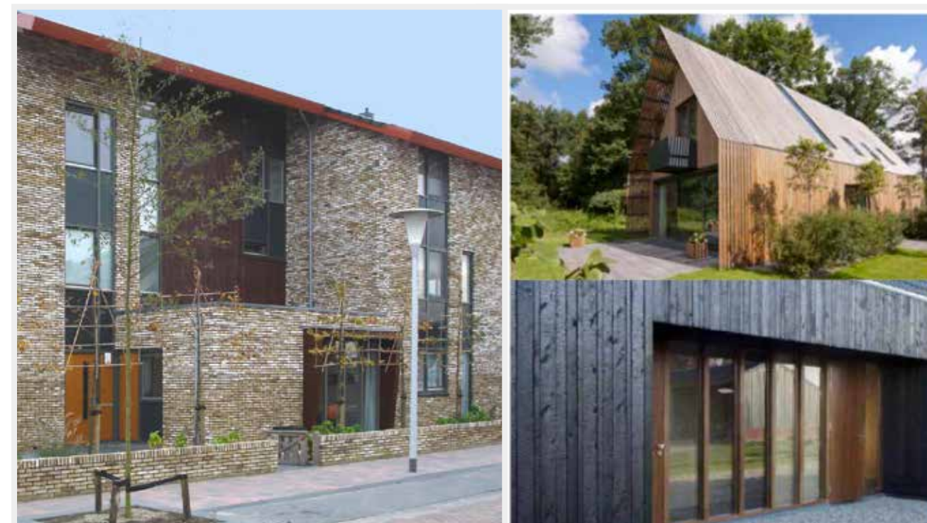
Verschillende kleurtoepassingen van hout: Links: hout gebeitst in natuurlijke bruine kleur Rechtsboven: hout natuurlijke vergrijzing Rechtsonder: hout met shou sugi ban behandeling
