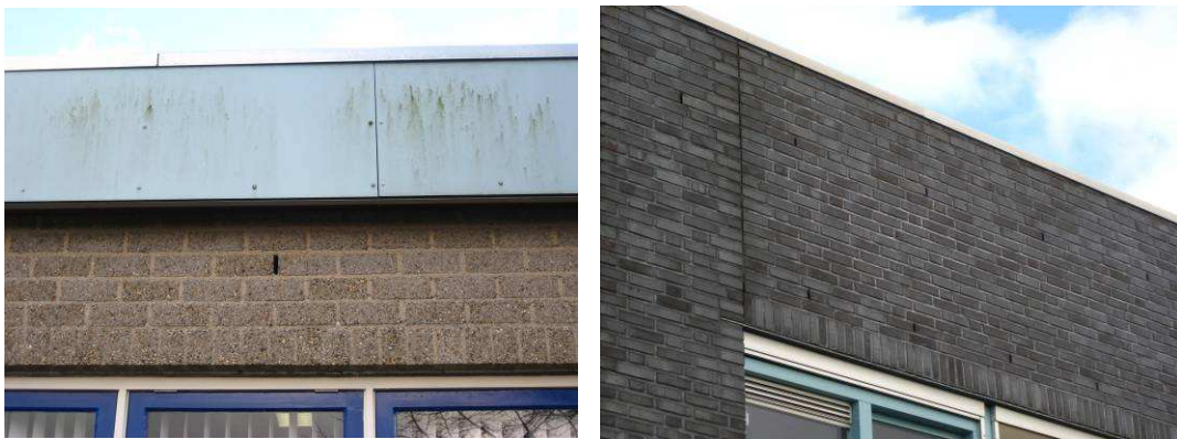
Afbeelding 5.2: Spouwmuurgaten in twee verschillende gebouwen binnen het plangebied.
