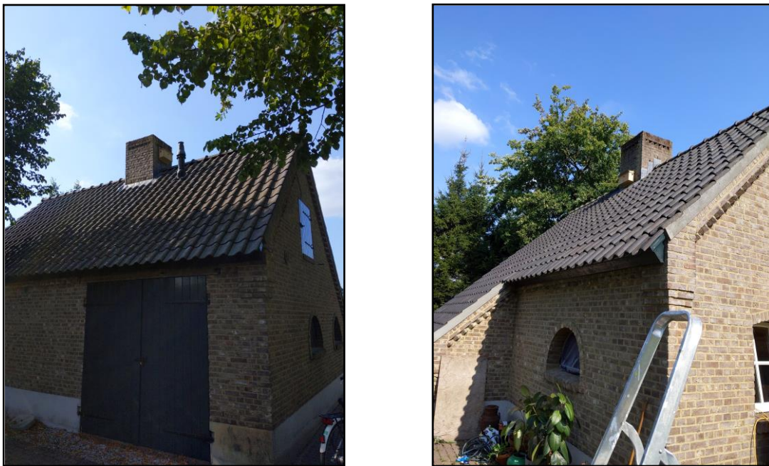
Figuur 5. De geplaatste tijdelijke koloniekasten tegen de noord- en de oostkant van de schoorsteen van het bakhuisje.
