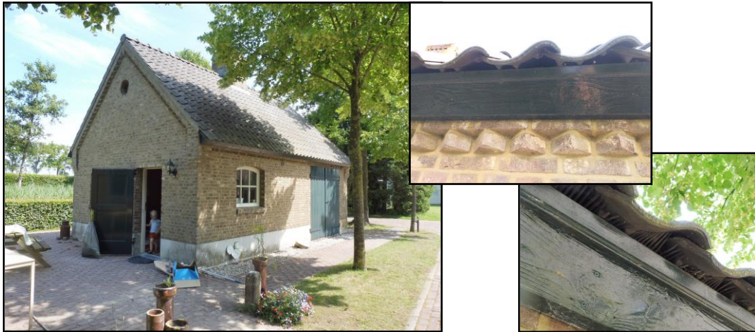
Figuur 4. Alle vogelschroot onder de zijgevels van het bakhuisje is verwijderd waardoor tijdelijke én permanente nestplekken zijn ontstaan.
