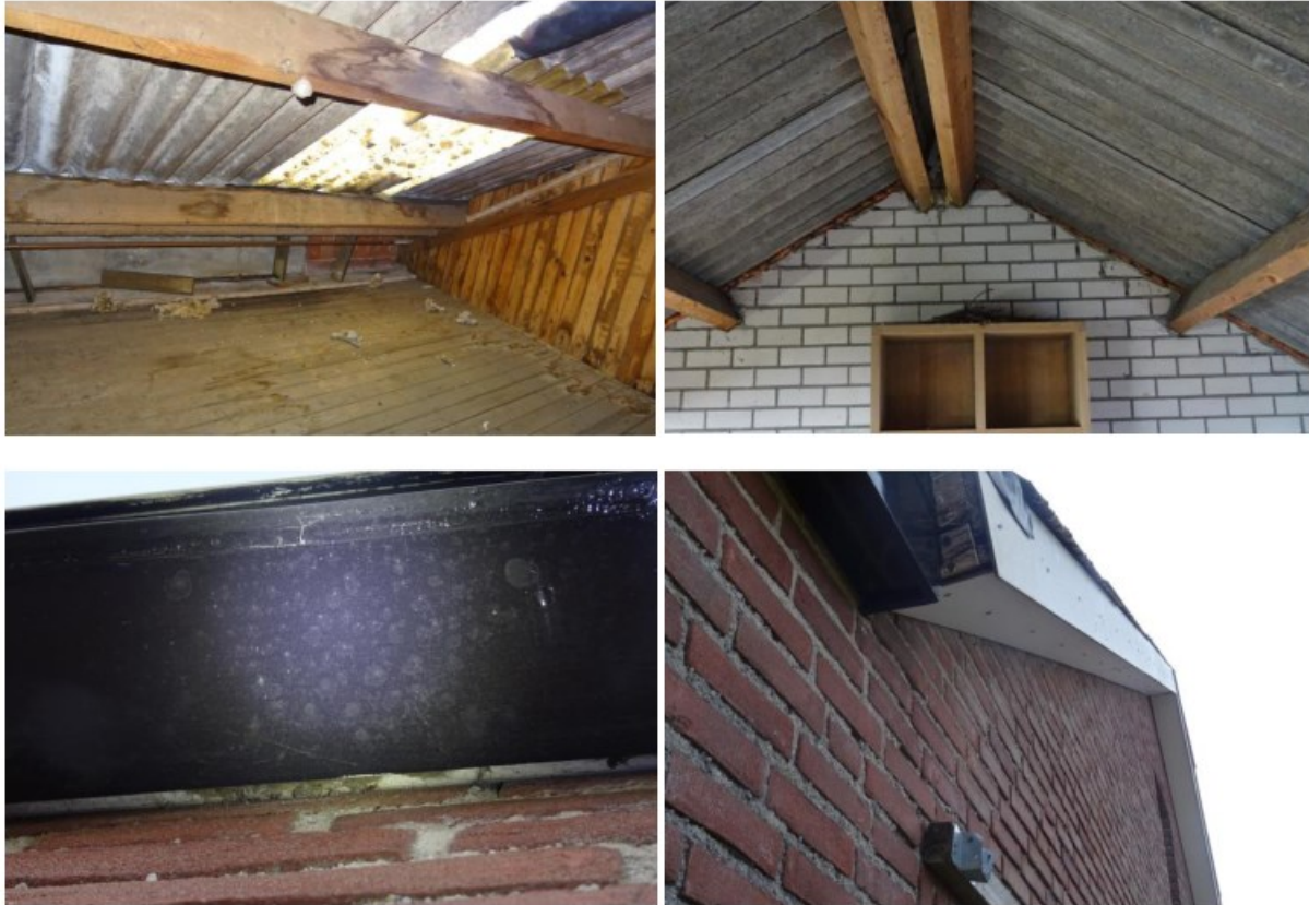
Afbeelding 9 t/m 12: Afwezigheid van mogelijk geschikte openingen naar verblijfruimten voor vleermuizen. Dit door deels de afwezigheid van dakbeschot, de afwezigheid van dakpannen/ deels plat dak, de aanwezige dwarslat onder boeiboorden/ gevelbekleding zonder geschikte gaten/ kieren, kieren en spleten zijn afgedicht met purschuim. Bron: . Datum: 04-04-2021
