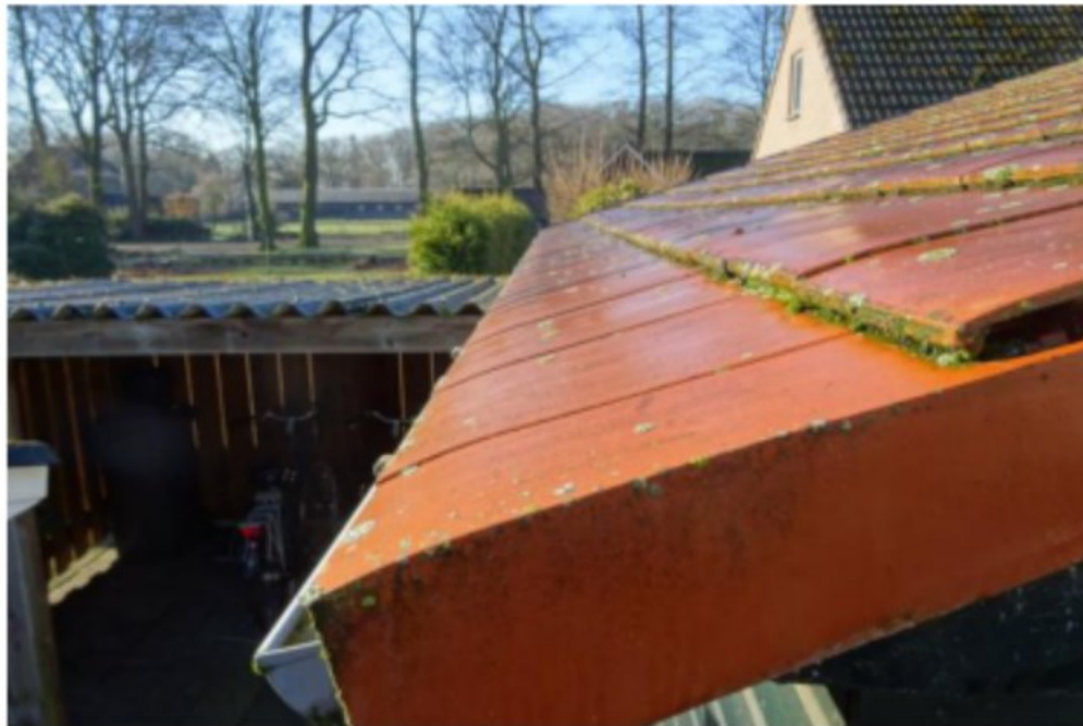
Afbeelding 15 t/m 18: Afwezigheid van mogelijk geschikte openingen naar verblijfruimten voor vleermuizen. Dit door deels de afwezigheid van dakbeschot, de vorm van dakpannen, de aanwezige dwarslat onder dakpannen en boeiboorden/ gevelbekleding zonder geschikte gaten/ kieren. Bron: [REDACTED] Datum: 05-03-2021
