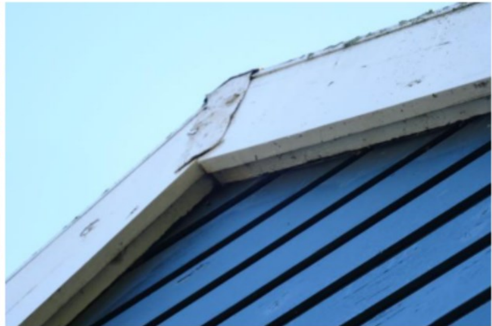
Afbeelding 15 t/m 18: Afwezigheid van mogelijk geschikte openingen naar verblijfruimten voor vleermuizen. Dit door deels de afwezigheid van dakbeschot, de vorm van dakpannen, de aanwezige dwarslat onder dakpannen en boeiboorden/ gevelbekleding zonder geschikte gaten/ kieren. Bron: [REDACTED] Datum: 05-03-2021
