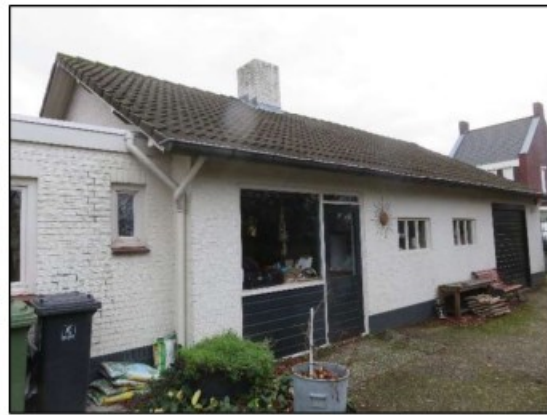
Foto 2. Westzijde van de schuur
