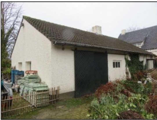
Foto 1. Oostzijde van de schuur
