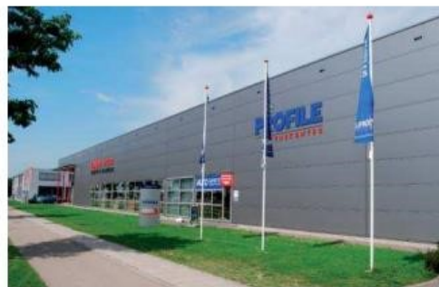
bedrijfsnaam op de gevel, bord en vlaggenmasten
