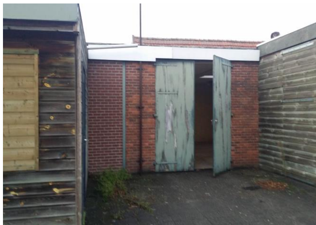
Detail te slopen bedrijfsgebouwen.
