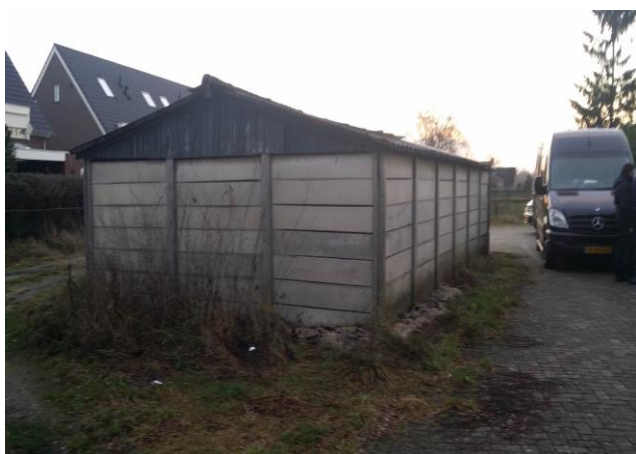
Te slopen schuurtje van betonpanelen.
