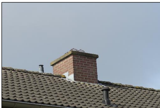
Foto 4. Dak woning aan de Drossard Meijerstraat
