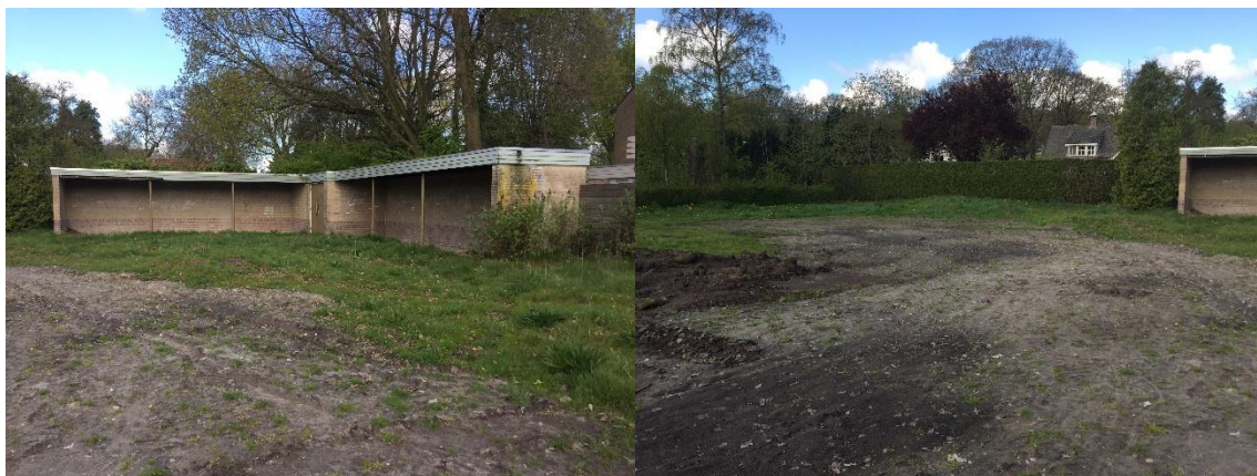
Figuren 1 en 2: Overzichtsfoto's onderzoekslocatie.
