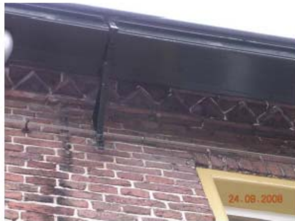
muizentand ter hoogte van de bakgoot voorgevel Keuken in aanbouw lange gevel noord.
