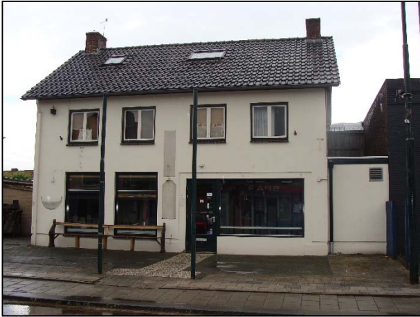
Foto 1. Voorzijde te slopen voormalig cafépand
