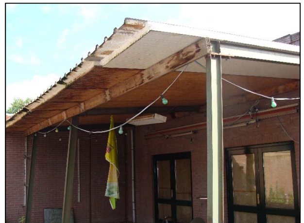
Foto 6. Te slopen overkapping
