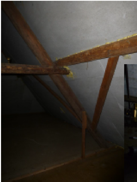
Nieuw en oude faka(?) sportwerk in de kap van het staldeel en woondeel.
