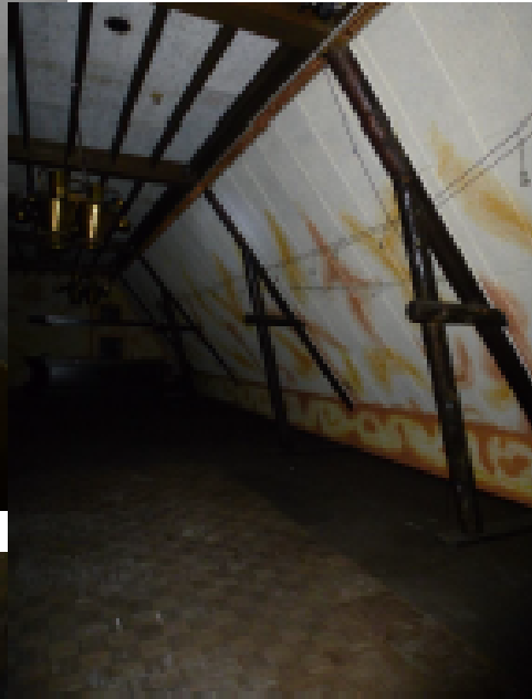
Nieuw en oude faka(?) sportwerk in de kap van het staldeel en woondeel.
