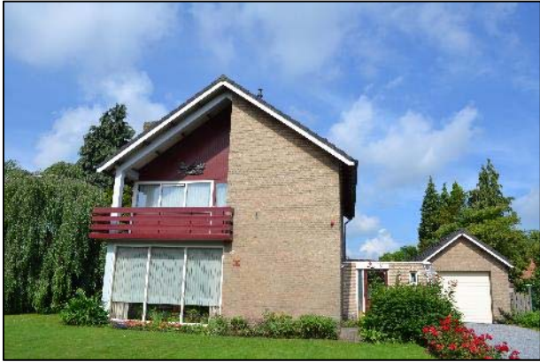
Foto 1. Voorzijde te slopen woonhuis met aanbouw en garage
