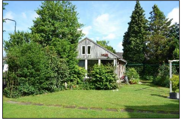
Foto 2. Voorzijde te slopen schuur
