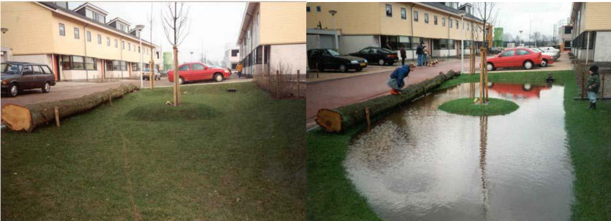
Afbeeldingen 4.2 en 4.3: voorbeeld van een kleine wadi voor en na een bui
