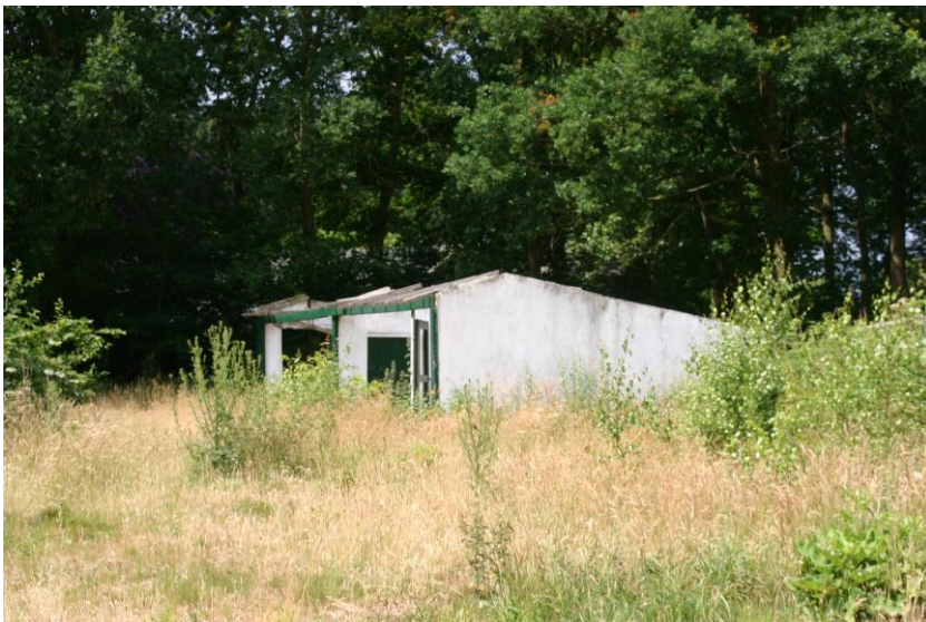
Figuur 4.1.3. Een van de twee bijgebouwtjes (2 in figuur 4.1.1).
