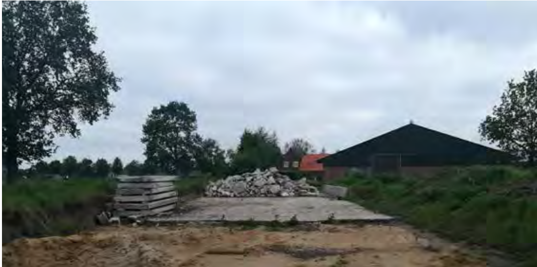
De deels gesloopte sleufsilos.
