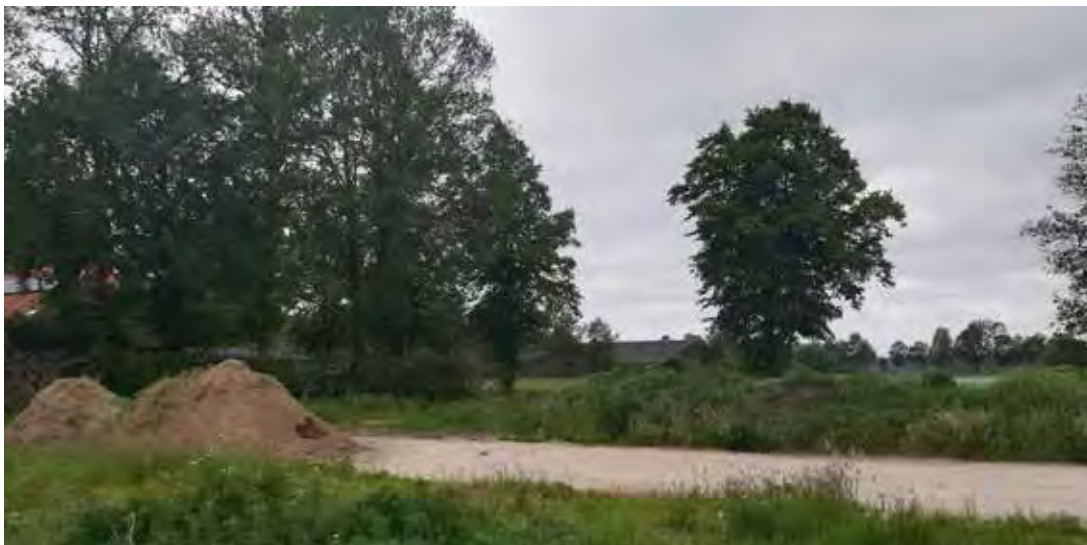
De deels gesloopte sleufsilos.
